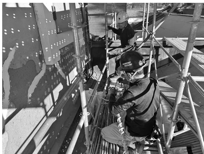
▲竹小舞を補修して荒壁を付け直す
